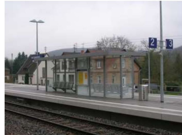
Abb.: Wartehaus auf dem Bahnsteig
